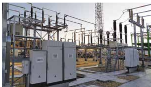
ОРУ ЦПС 110 кВ «ГПП-9» выксунского завода ОМК
